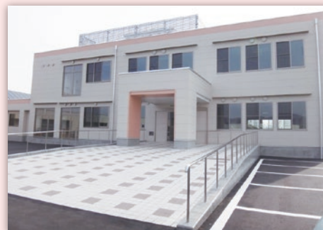
↑2階建ての避難棟。
