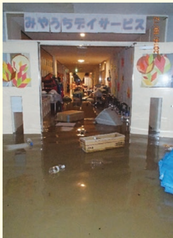
↑写真2 水没した1階のデリラウンジ
